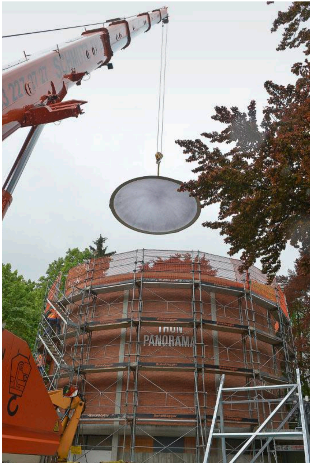
Ein Spezialkran im Schadaupark in Thun: Eine neue Kuppel für das Thun-Panorama wird geliefert. Nun beginnt die Restaurierung des Rundgebäudes.
